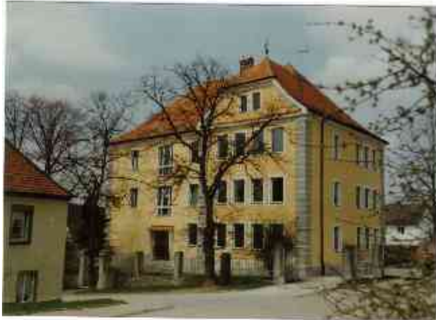
Das ehemalige Finanzamtsgebäude in Velburg
